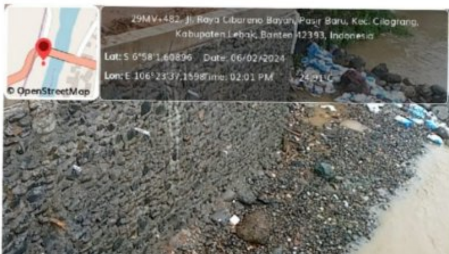
Foto Titik Lokasi Pembangunan Penahan Jembatan
