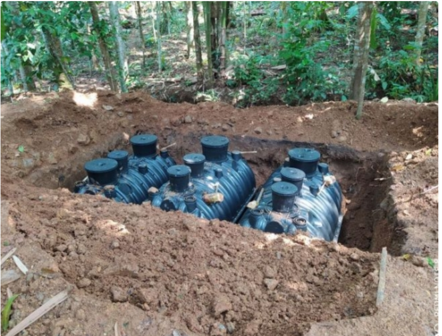
Pemasangan Septic tank pada program IPAL Komunal
