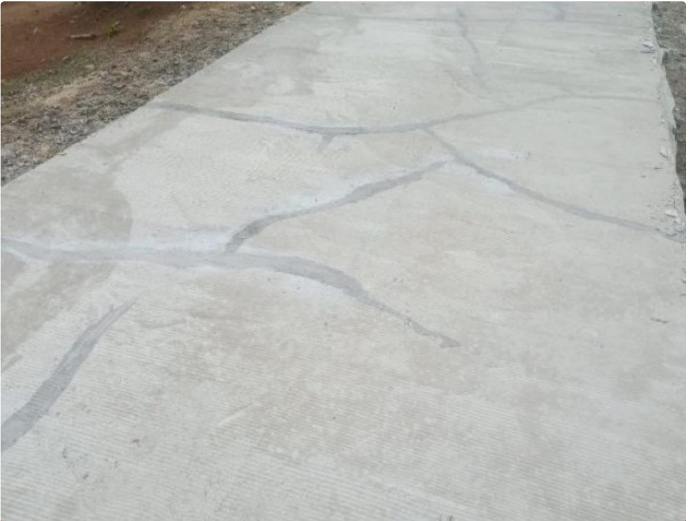
*Pekerjaan beton yang belum lama dikerjakan nampak retak*
