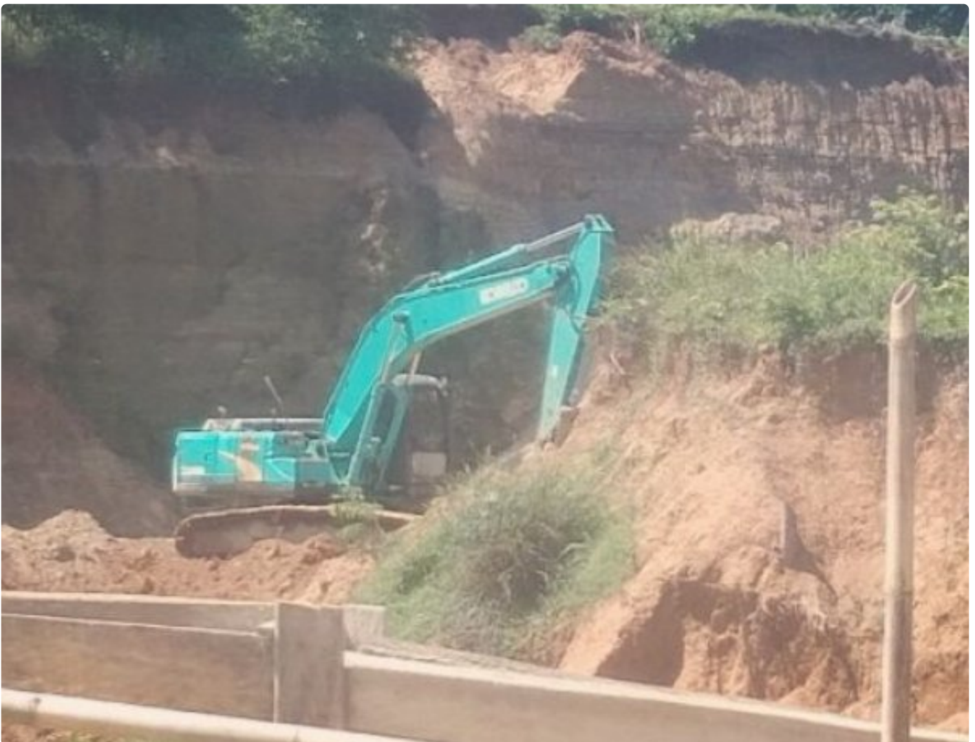
Nampak lokasi tambang pasir diduga ilegal dan menggunakan alat berat
